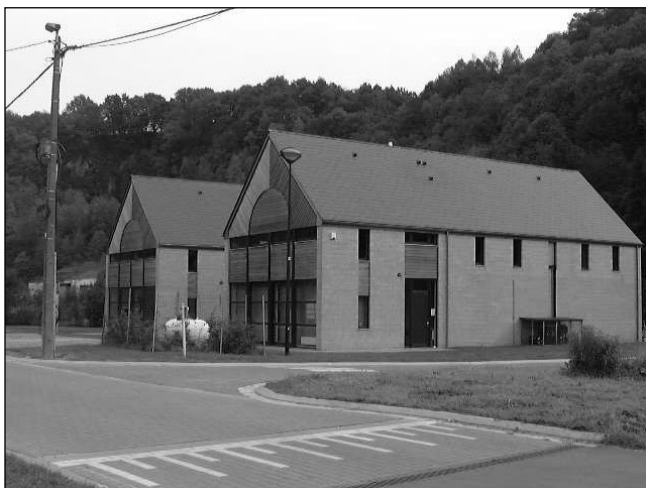
Bâtiments relais de la SPI+ à Comblain-au-Pont.
