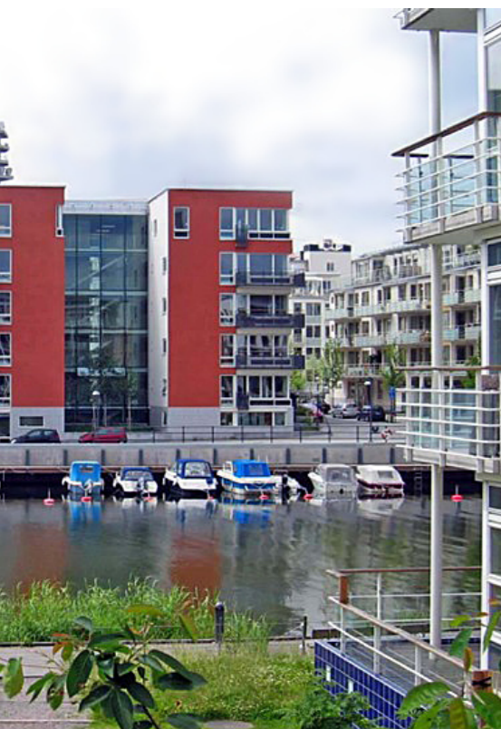
Dans le quartier d'Hammarby Sjöstad, la municipalité de Stockholm a fixé des niveaux performance énergétique ambitieux : à l'horizon 2005, la consommation des logements devait être inférieure à 60kWh/m 2 , dont 20kWh/m 2 pour la consommation électrique. D'ici 2015, elle devra descendre à 50kWh/m 2 dont 15kWh/m 2 pour l'électricité !
